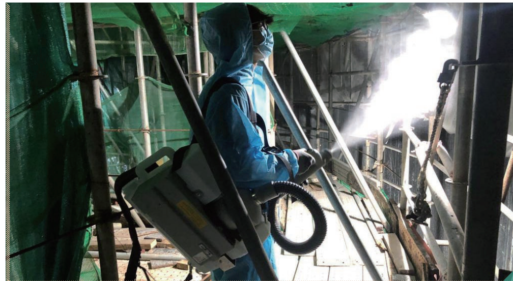
■ 工地辦公室噴灑納米塗層和配置具有高效空氣微粒篩檢程式 (HEPA) 或氧聚解空氣處理技術的空氣清新機
