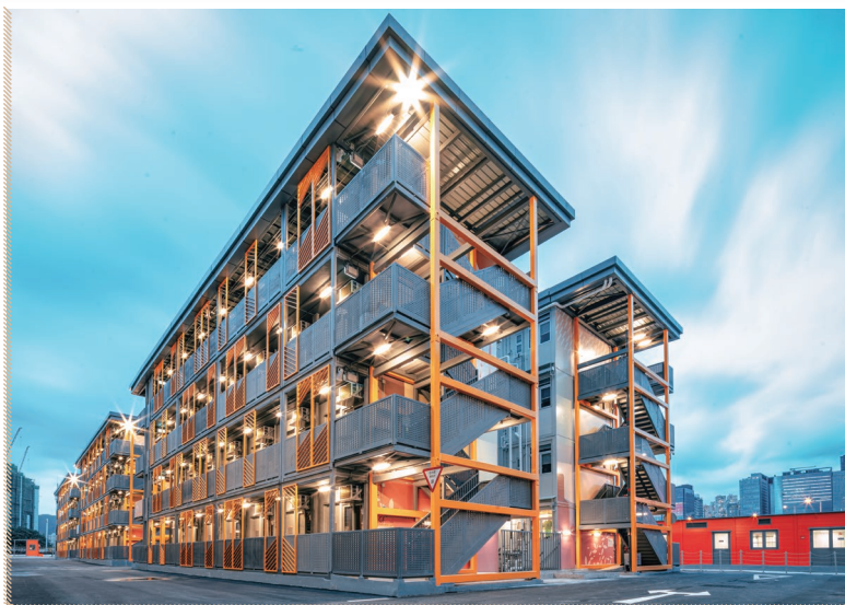
■ 啟德郵輪碼頭社區隔離設施
