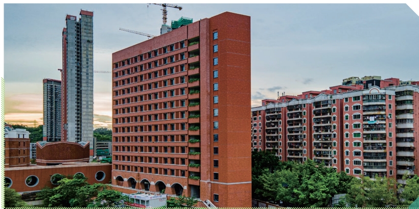
■ 深圳中學（泥崗校區）學生宿舍新增電梯一號樓
