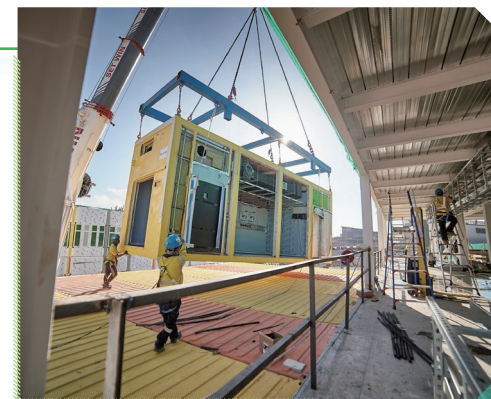
■ MiC 施工現場
